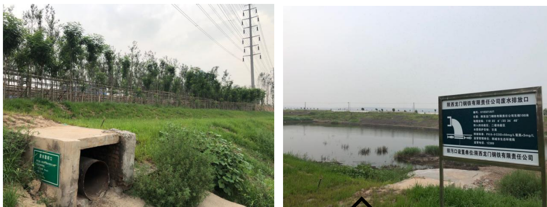
图 8.2.3 龙钢公司污水排放口图片
